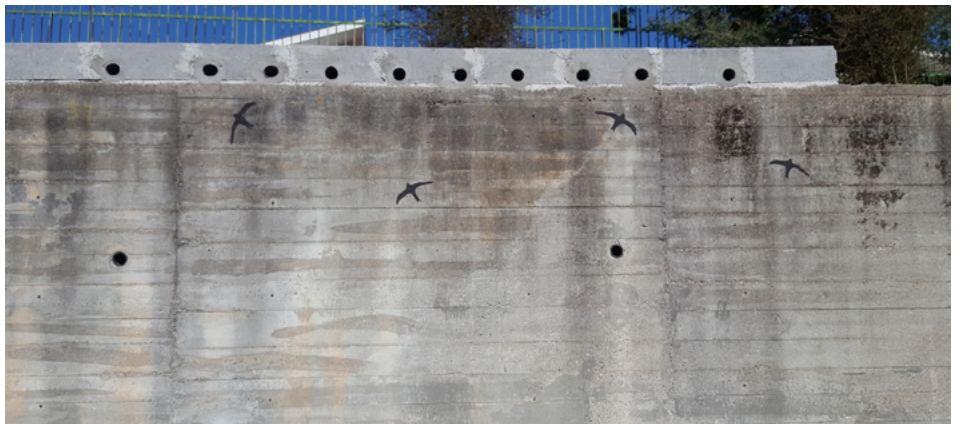
FIGURA 1. Locais de nidificação no muro da escola.
