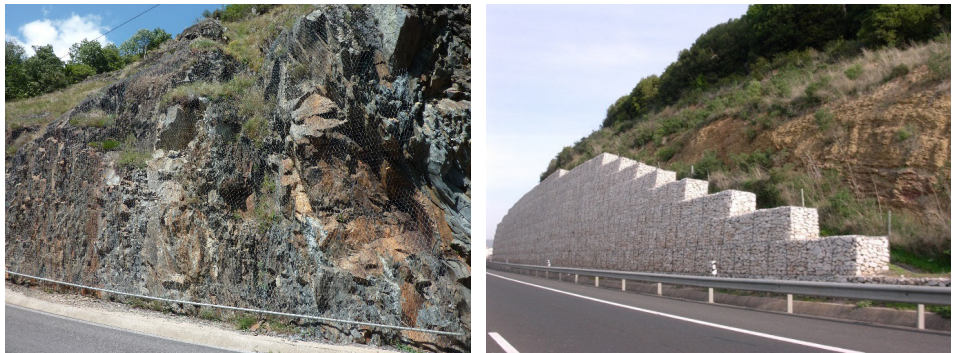
FIGURA 5. Medidas de contenção colocadas em taludes junto a estradas, garantindo a estabilidade durante a vida útil da obra.
