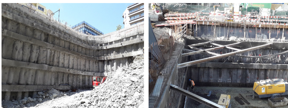
FIGURA 2. Fundações de edifícios em ambiente urbano: escavação e medidas de contenção periférica.
