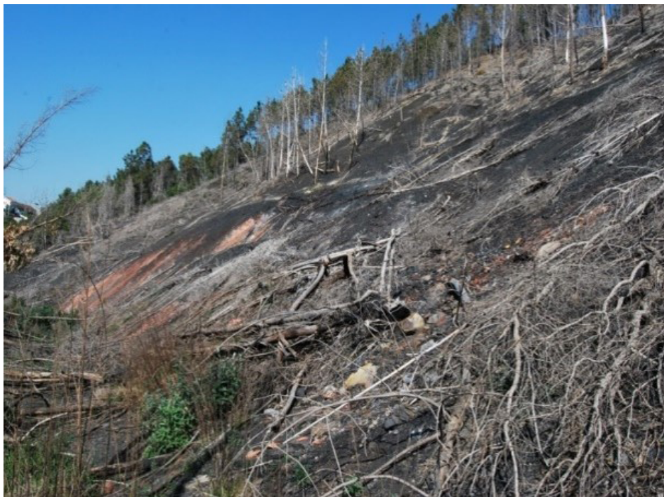
FIGURA 2. Visão geral da vertente exposta a SW da escombreira de São Pedro da Cova após autocombustão; note-se a vegetação queimada, a instabilidade do talude e a coloração avermelhada do material da escombreira devido à formação de óxidos de ferro durante a combustão.
