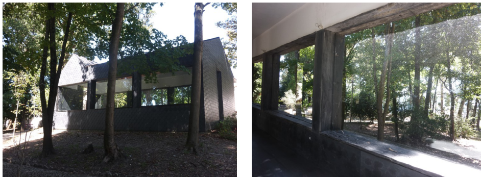
FIGURA 2. Edifício multiusos (vistas exterior e interior) para atividades experimentais em área coberta.
