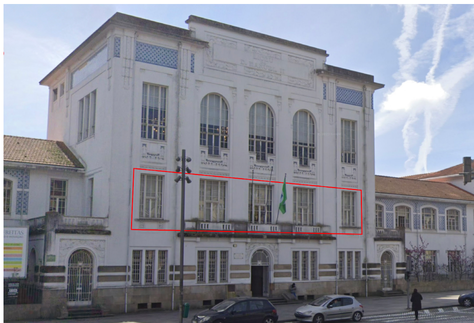
FIGURA 1. Fachada principal da atual Escola Básica e Secundária Rodrigues de Freitas. (O Museu situa-se no espaço delimitado na imagem pelo retângulo vermelho).
