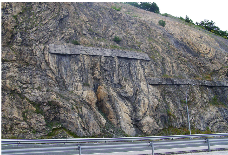
FIGURA 2. Dobramentos espetaculares em terrenos paleozoicos patentes nos taludes da autoestrada AP66, imediatamente a sul da fronteira entre o Principado das Astúrias e a região de Castela-Leão (Província de Leon).
