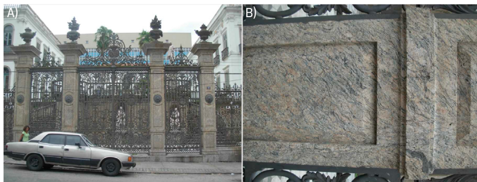
FIGURA 4. A) Edifício da antiga Beneficência Portuguesa no Rio de Janeiro. B) Portão do referido edifício construído a partir da rocha que caracteriza grande parte da cidade: o gnaíse facoidal.
