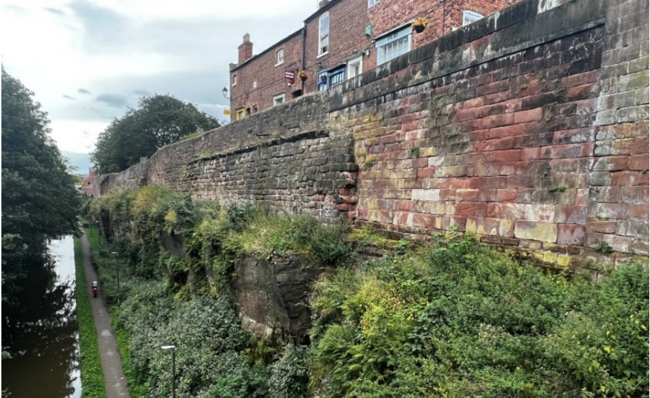
FIGURA 8. Aspeto da muralha de Chester assente em rochas siliciclásticas (arenosas e conglomeráticas) do Triásico Inferior (base do Grupo Sherwood Sandstone).
