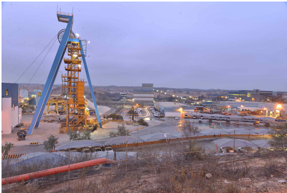
FIGURA. 1. O poço de extração do minério de Neves Corvo e a área industrial envolvente. Fonte: https://somincor.com.pt/en/operation/ .
