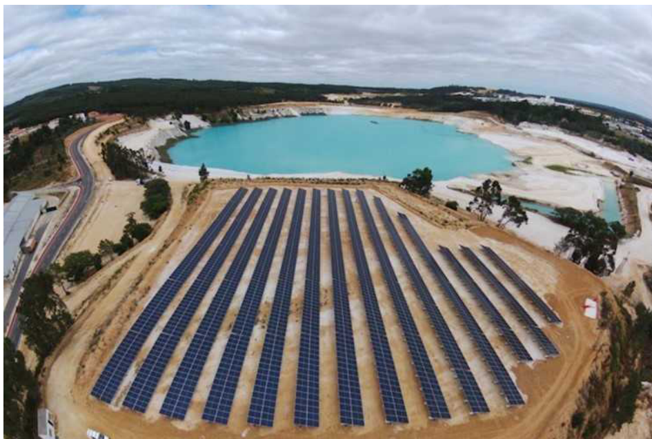
FIGURA 2. A exploração de areia siliciosa da empresa SIBELCO, em Rio Maior. Fonte: https://www.sibelco.com/en/locations/rio-maior .
